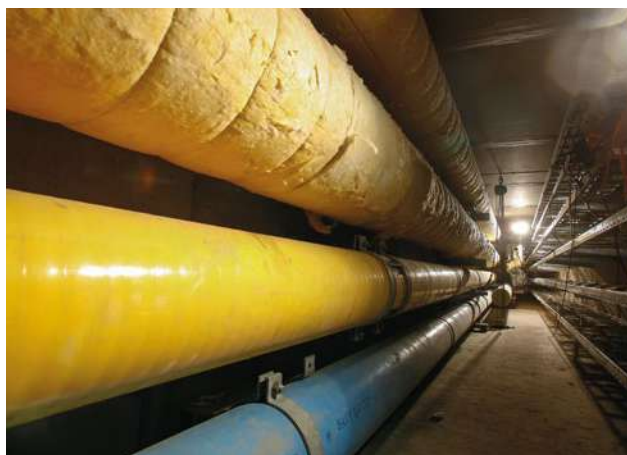
INRAG Projektbeispiel: Fernwärme Untertunnelung des Flusses Wiese in Basel
