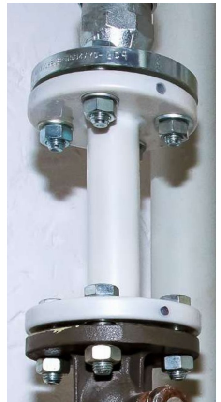
Einsatz von KYBURZ Isolier-Flanschen
